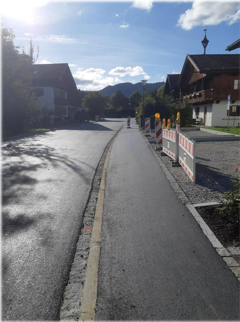
In der Bahnhofstrasse wurde die in die Jahre gekommene Wasserleitung erneuert. In diesem Zug wurden eine Gasleitung und Glasfaserkabel mitverlegt sowie vom Bayernwerk die Stromkabel erneuert. Im Anschluss daran ist auch der Gehsteig verbreitert worden.
