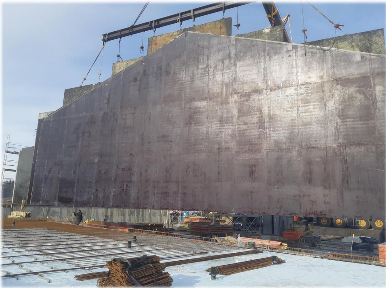
Umbau der 220 m<sup>2</sup> Außenschalung für die Ost- und Westliche Giebelwand mit knapp 20 Tonnen Gewicht
